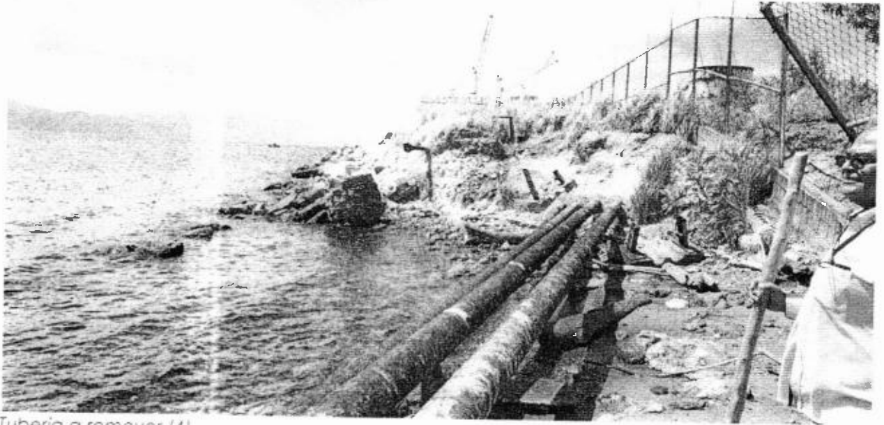
Tubería a remover (4)
