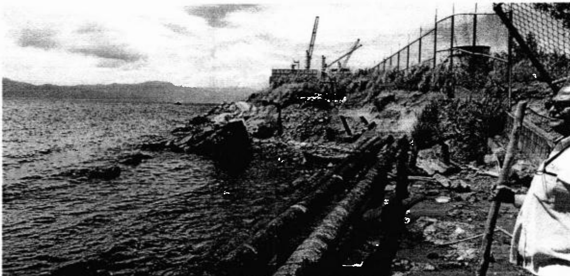
Tubería a remover (4)
