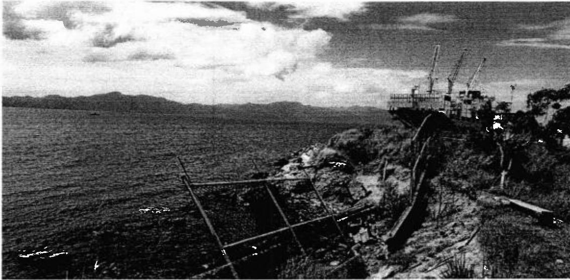
Sección de cerco Afectada
